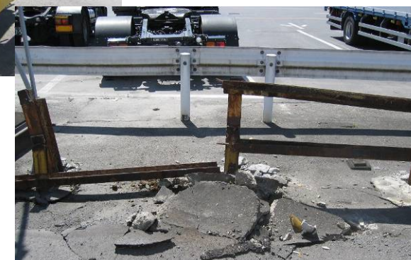
ガードレール破損
