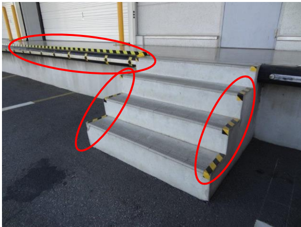
⑤ プラットホーム、階段端部にトラテープを貼付し墜落・転落防止の注意喚起
