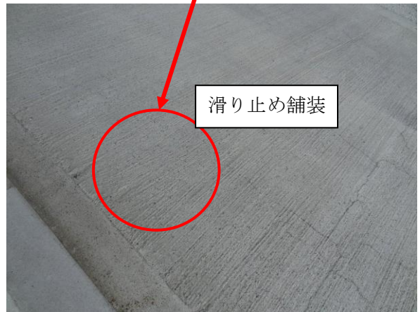
⑥ 傾斜通路に滑り止め対策実施
