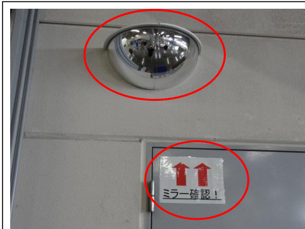
① 死角部分にミラー設置 衝突防止に努力
