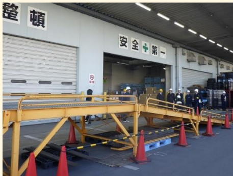
▲コンテナ車へのアプローチ用の フォークリフト専用スロープ
