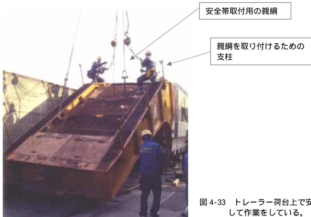
図 4-33 トレーラー荷台上で安全帯を使用して作業をしている。
