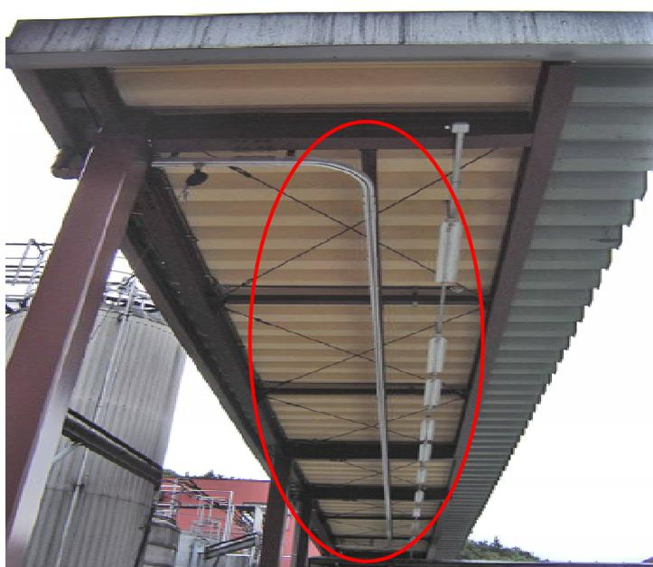
図 4-32 建屋天井に設置したレール。運転手が安全帯を着けても移動できるようにしている。
