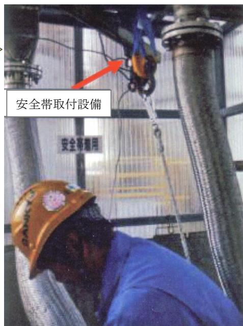
図 4-30 タンクローリー上部の建屋内に設置された安全带取付設備
