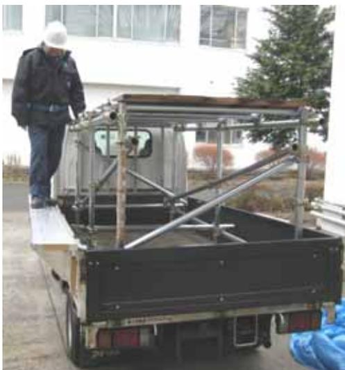
図 3-1 簡易作業床をあおりに取り付け歩行している様子
